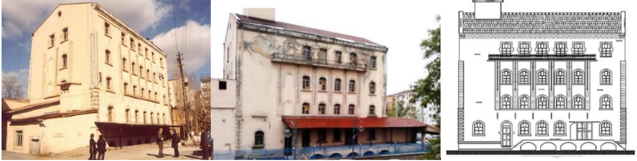
Görüntü 10: Azm-i Milli Tarihi Un Fabrikası kuzey cephesi restorasyon öncesi ve sonrası Aksaray Belediyesi arşivi, Celal Güven arşivi, 2021
